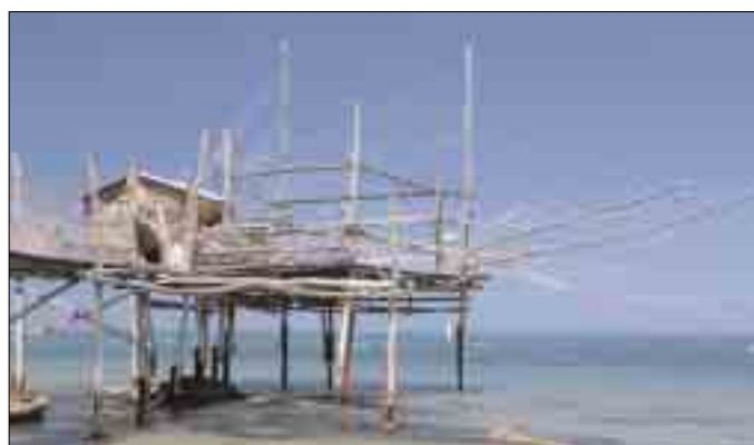
Zeugnisse traditioneller Fischerei: die „Trabocchi“, Pfahlbauten aus Holz.
