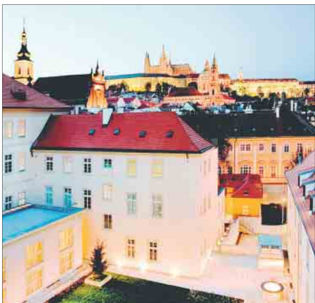
Außen klösterlich, innen luxuriös: Das Mandarin Oriental hat seit dem Umbau viel an Charakter gewonnen.
